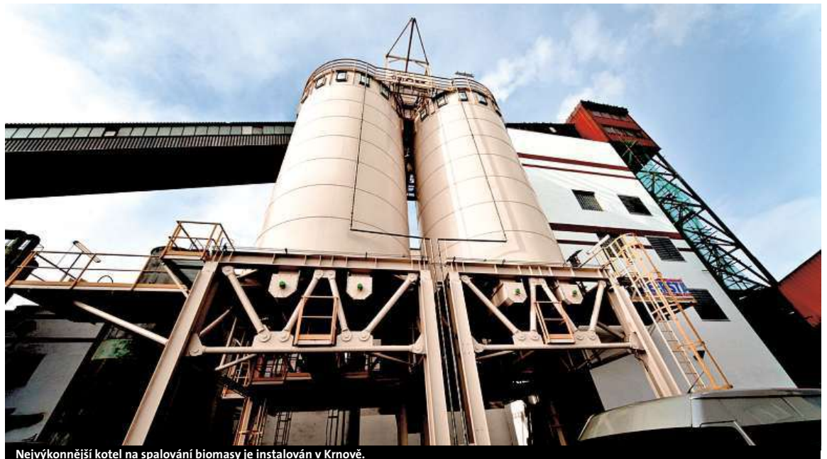
Nejvýkonnější kotel na spalování biomasy je instalován v Krnově.
