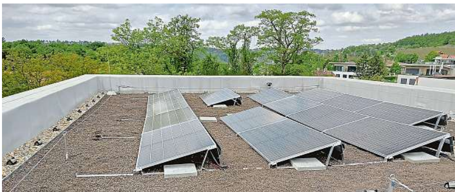
Po žebříku na střechu jedné ze dvou nových budov v Botanické zahradě v Troji jsme se vydali, abychom pro vás „ulovili“ fotografii několika zcela nových fotovoltaických panelů.
