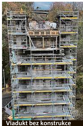
Viadukt bez konstrukce
