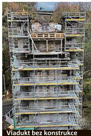
Viadukt bez konstrukce
