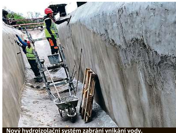
Nový hydroizolační systém zabrání vnikání vody.
