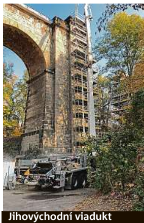
U jihovýchodního viaduktu se měnila i nosná konstrukce.
