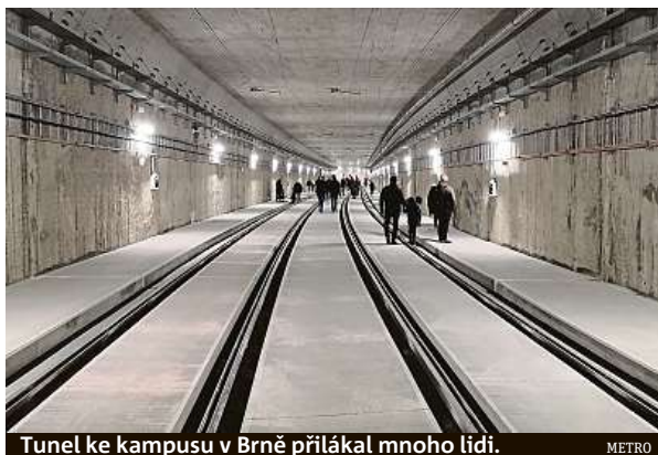
Tunel ke kampusu v Brně přilákal mnoho lidí.
