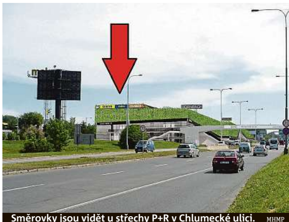
Směrovky jsou vidět u střechy P+R v Chlumecké ulici. MHMP
