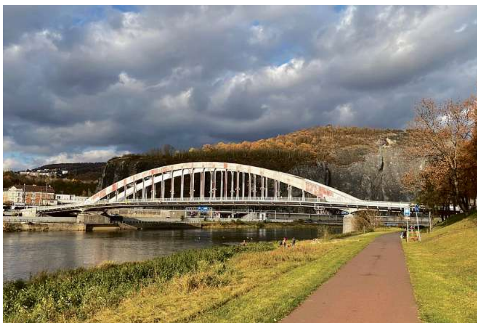
Most Edvarda Beneše v Ústí nad Labem čeká rekonstrukce.
