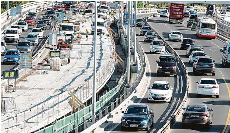
Cena za opravu Barrandovského mostu se téměř zdvojnásobila, vyjde na 1,1 miliardy. Nyní se pokládá vysokopevnostní beton. Ten se pak překryje litym asfaltem a následně asfaltobetonem.
