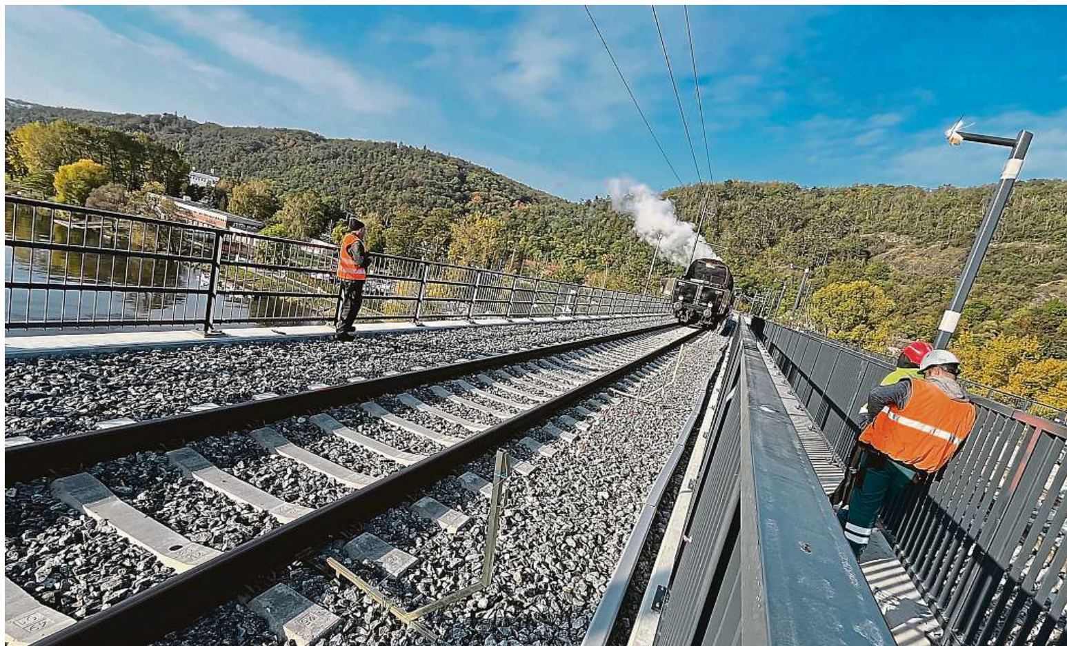
Most byl vyprojektován s označením ÚM 950, což je zkratka pro údolní most délky 950 metrů. Nově má jeho pěší stezka i zábradlí.
