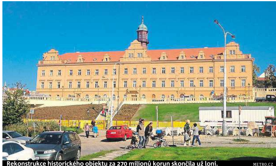
Rekonstrukce historického objektu za 270 milionů korun skončila už loni.
