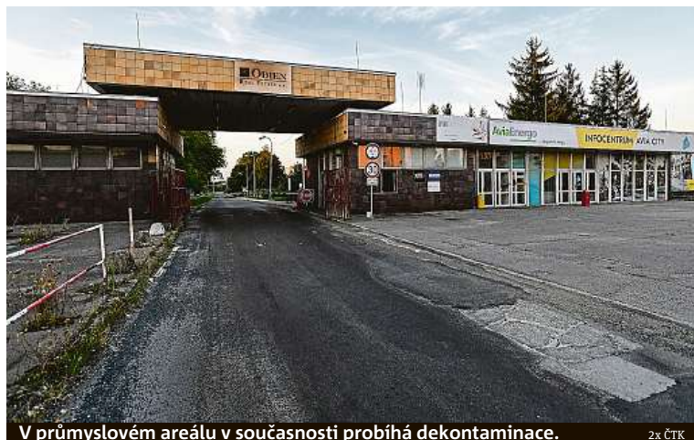
V průmyslovém areálu v současnosti probíhá dekontaminace.
