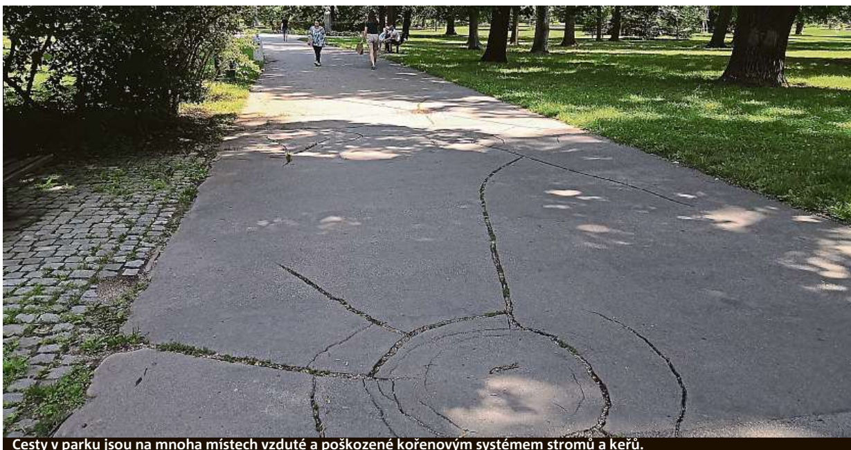
Cesty v parku jsou na mnoha místech vzduté a poškozené kořenovým systémem stromů a keřů.
