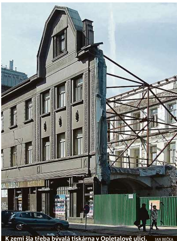
K zemi šla třeba bývalá tiskárna v Opletalově ulici. JAN BEČKA
