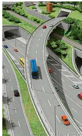
Pohled na most rampy mimoúrovňové křižovatky na Zličově RADLICKARADIÁLA.INFO
