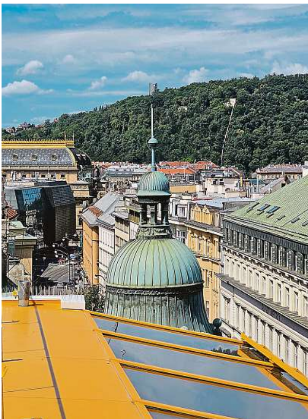
Věž domu na nároží Spálené ulice a Národní třídy jste takhle ještě neviděli. V popředí je zaoblená prosklená část pláště budovy.
