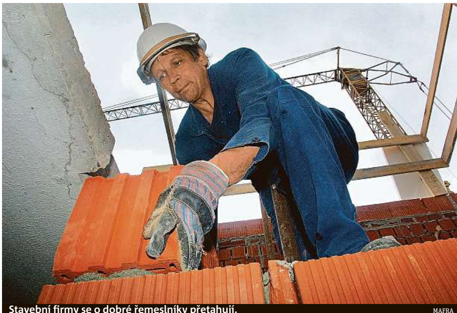
Stavební firmy se o dobré řemeslníky přetahují.
