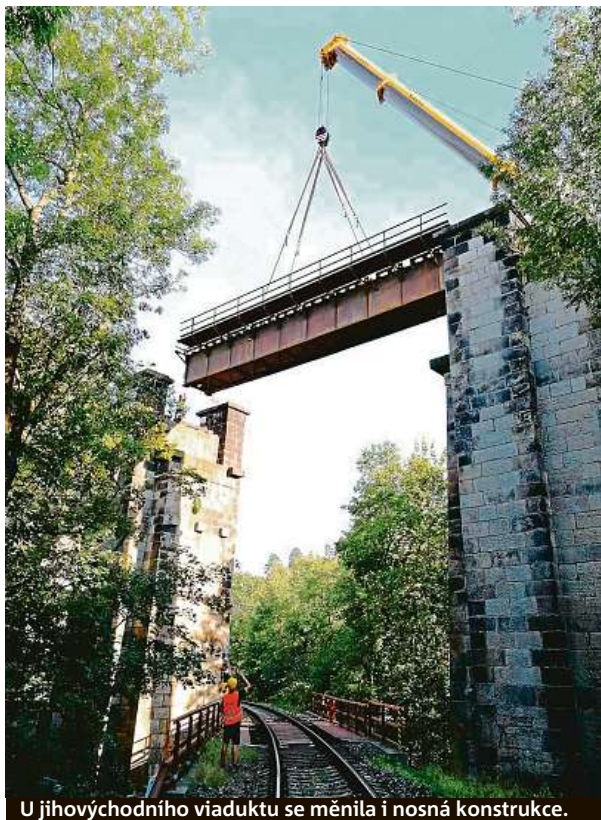
U jihovýchodního viaduktu se měnila i nosná konstrukce.
