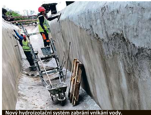
Nový hydroizolační systém zabrání vnikání vody.
