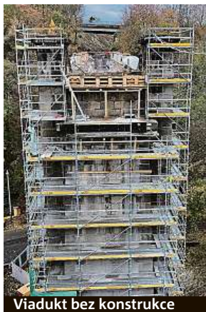
Viadukt bez konstrukce
