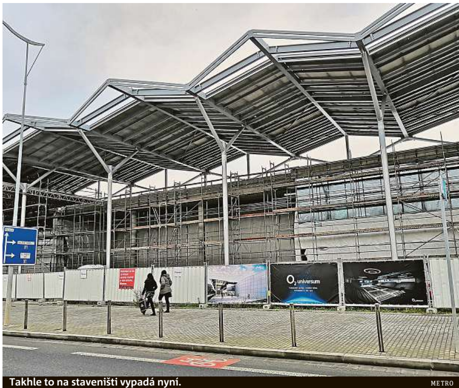
Takhle to na staveništi vypadá nyní. METRO
