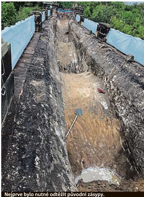
Nejprve bylo nutné odtěžit původní zásypy.
