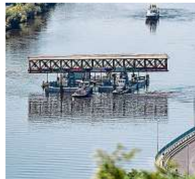
Přeprava nadměrné konstrukce ke Dvořeckému mostu MAFRA
