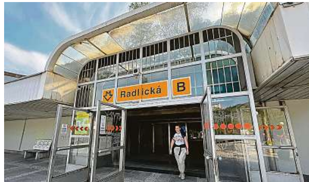
Vstup do stanice metra B Radlická
