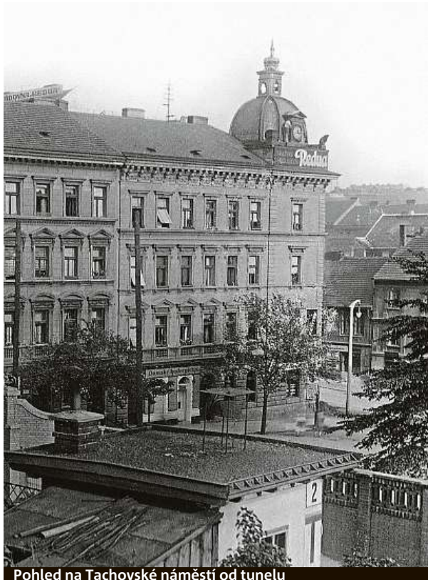
Pohled na Tachovské náměstí od tunelu
