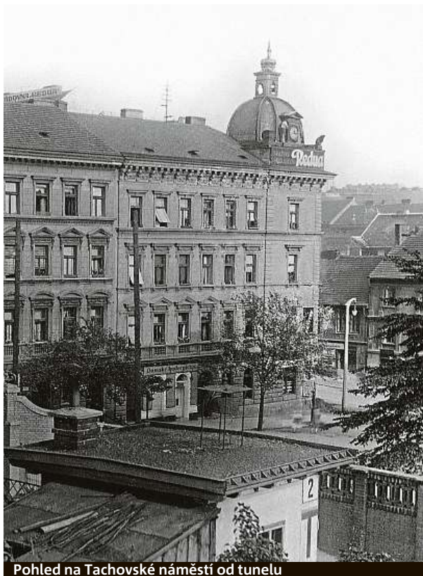
Pohled na Tachovské náměstí od tunelu
