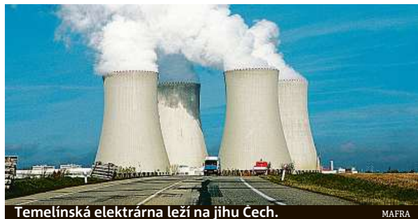
Temelínská elektrárna leží na jihu Čech. MAFRA
