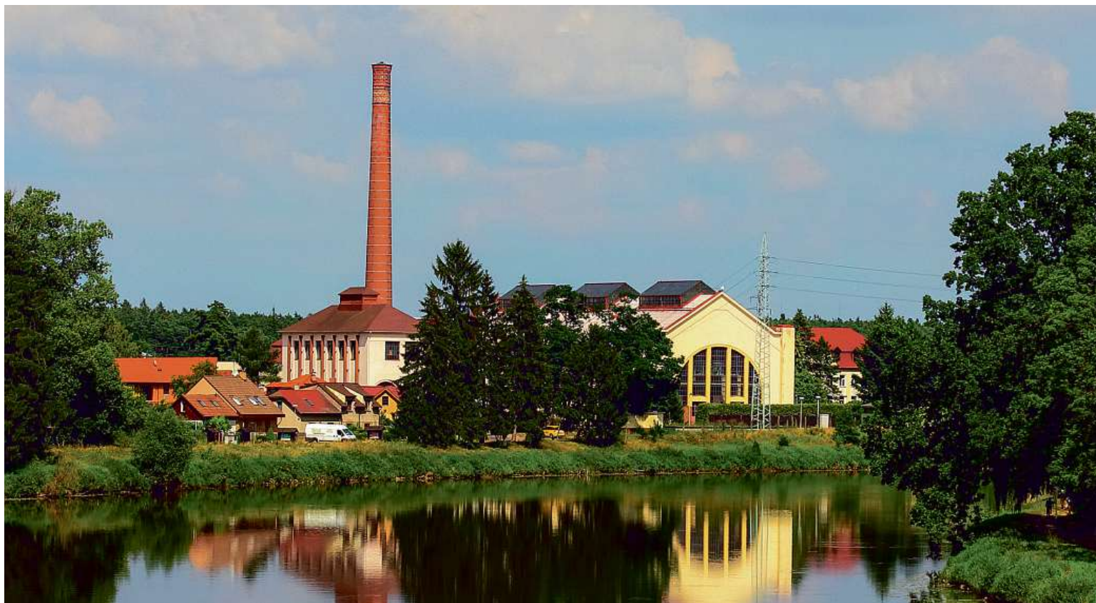
Káraná vodárna jako nejkvalitnější zdroj vody pro Prahu prošla modernizací.
