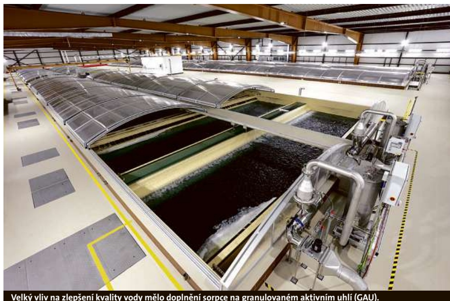
Velký vliv na zlepšení kvality vody mělo doplnění sorpce na granulovaném aktivním uhlí (GAU).
