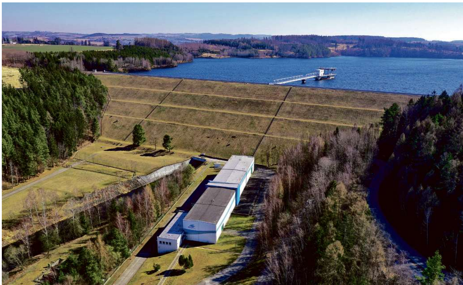
Vodní nádrž Švihov a Úprava vody Želivka zajišťují dostatek kvalitní vody pro Prahu.
