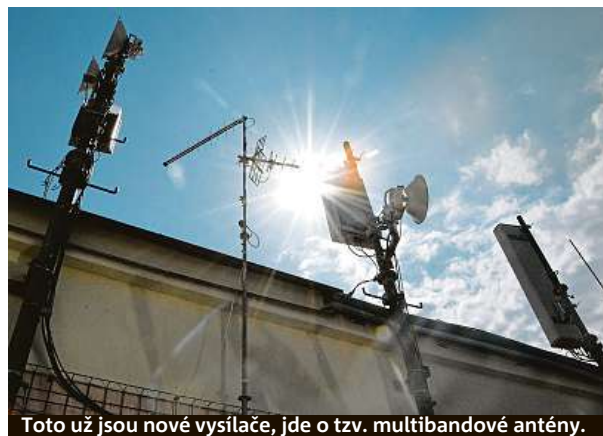
Toto už jsou nové vysílače, jde o tzv. multibandové antény.
