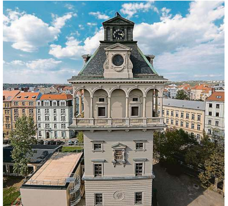
Vodárenská věž na Letné je součástí akce Open House Praha pravidelně. Jedním z lákadel je například přístupný ochoz. FB VODÁRENSKÁ VĚŽ LETNÁ
