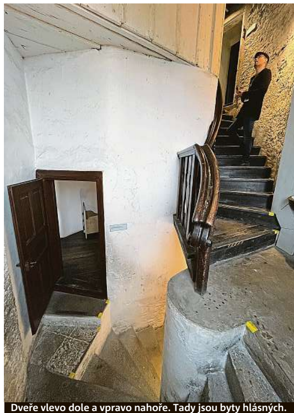
Dveře vlevo dole a vpravo nahore. Tady jsou byty hlásných.
