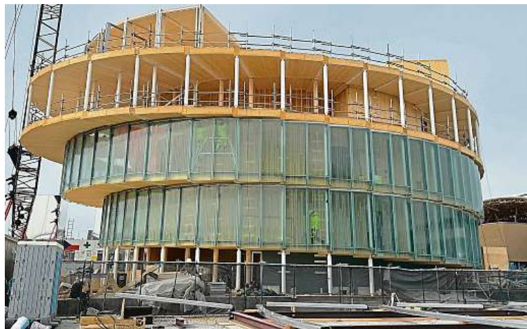
Foto z průběhu stavby, konkrétně z instalace skleněné fasády
