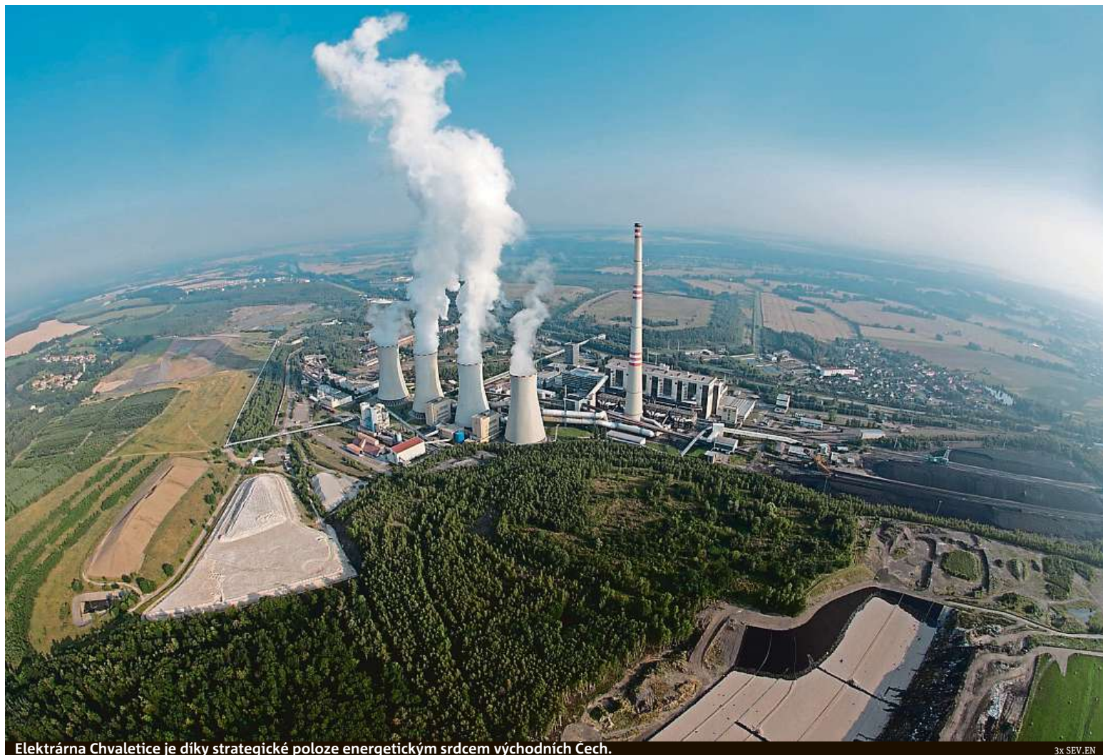
Elektrárna Chvaletice je díky strategické poloze energetickým srdcem východních Čech.
