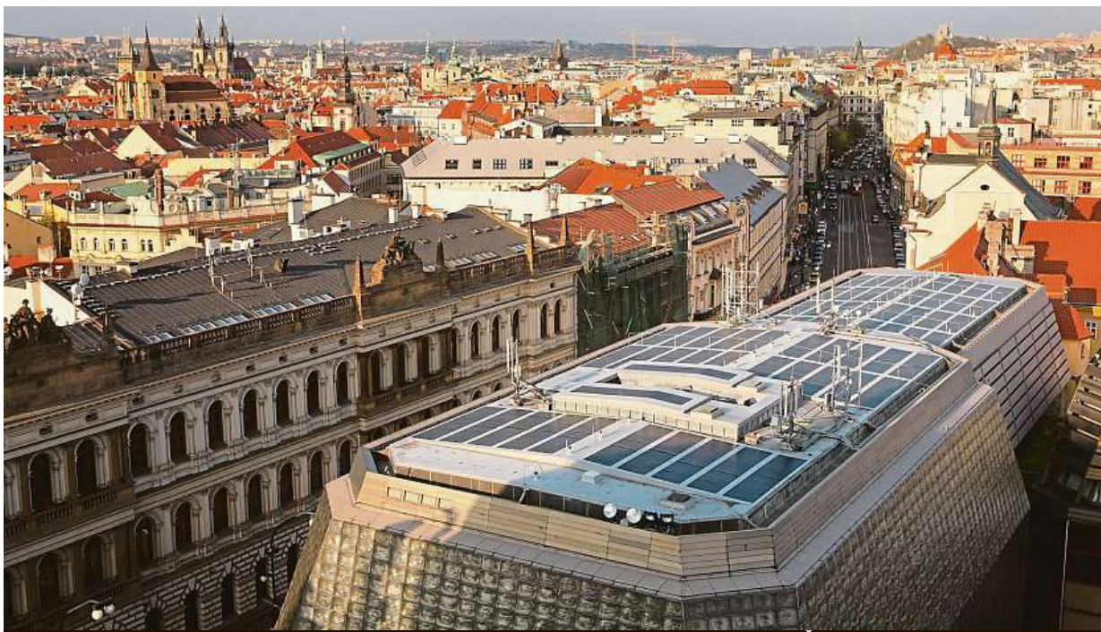
Solární panely mají na střeše některé pražské budovy již nyní. Další se chystají například na Černém Mostě.
