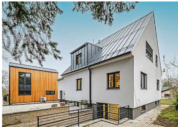
Vícegenerační dům v Uhřetěvesi. Příklad, jak lze vyřešit i nenadálou situaci v rodině. Případně bydlení pod jednou střechou. 2x CENTURY 21
