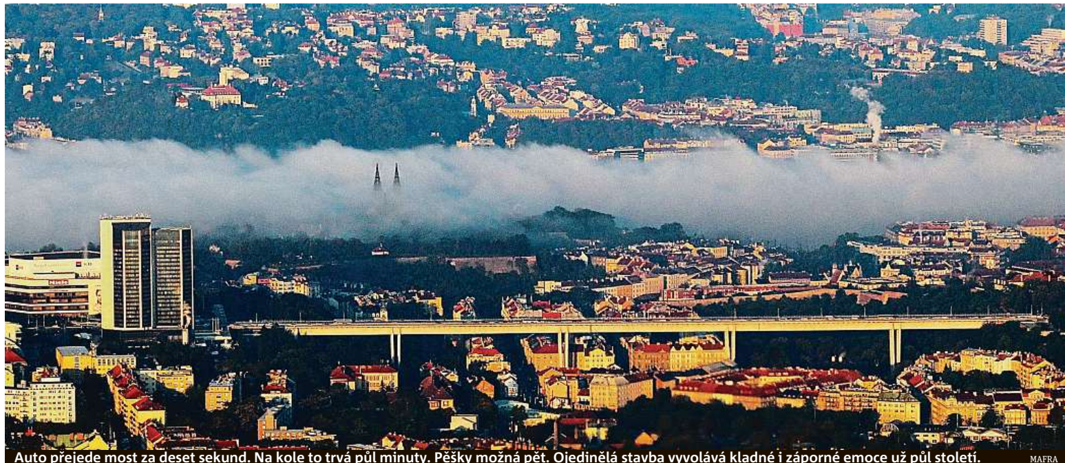
Auto přejezd most za deset sekund. Na kole to trvá půl minuty. Pěšky možná pět. Ojedinelá stavba vyvolává kladné i záporné emoce už půl století.
