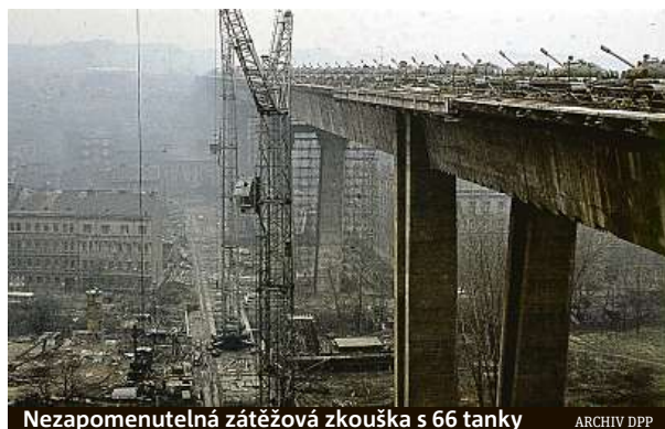
Nezapomenutelná zátěžová zkouška s 66 tanky
