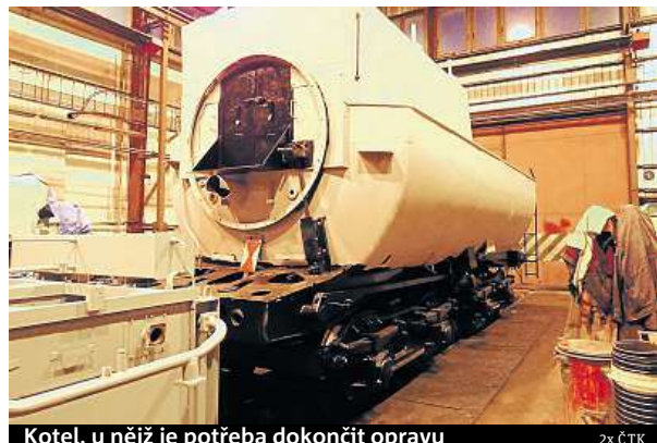
Kotel, u něž je potřeba dokončit opravu
