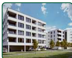
Bytové domy Břeclav, ul. Charvátská
