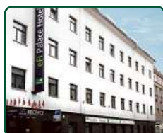
eFi Palace Hotel, Brno, dokončené 2 etapy
