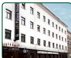
eFi Palace Hotel, Brno, dokončené 2 etapy
