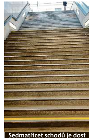
Sedmatřicet schodů je dost
