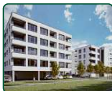
Bytové domy Břeclav, ul. Charvátská
