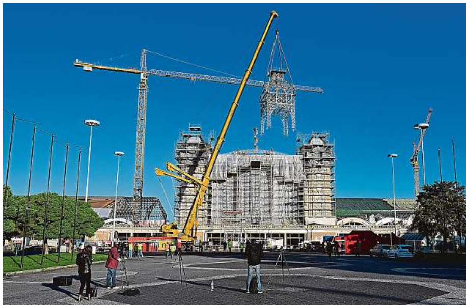
Práce na střeše Průmyslového paláce by měly být hotové do konce roku. Včera dělníci na palác opět nasadili hodinovou věž.
