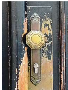
Nešvar. Aby se kování vešlo, dveře částečně vyfrézovali.
