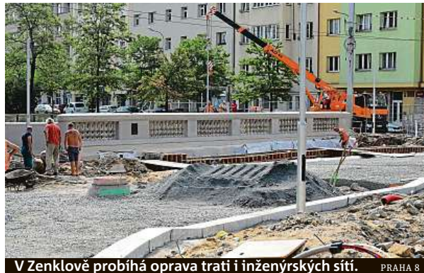
V Zenklově probíhá oprava trati i inženýrských sítí. PRAHA 8
