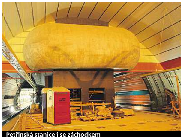
Petřinská stanice i se záchodkem
