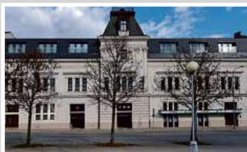
Multifunkční budova, Brno
