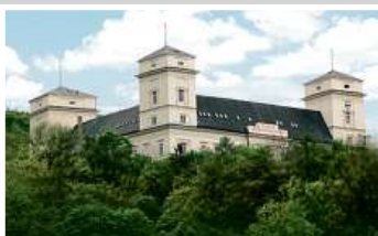
Zámek Račice, přestavba
