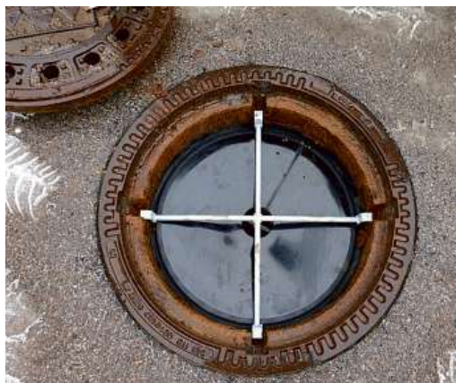
Biofiltr instalovaný v revizní šachtě kanalizace v ulici Ke Dráze
