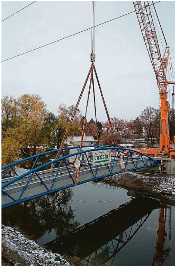
Na snímcích je usazování nové lávky.
