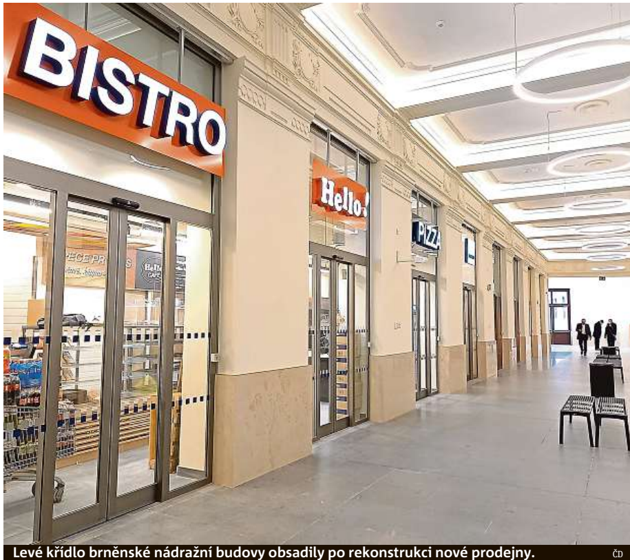
Levé křídlo brněnské nádražní budovy obsadily po rekonstrukci nové prodejny. ČD
