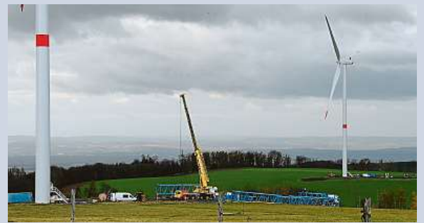
Výstavba větrných elektráren u Jívové na Olomoucku
