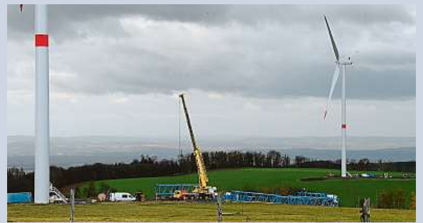
Výstavba větrných elektráren u Jívové na Olomoucku
