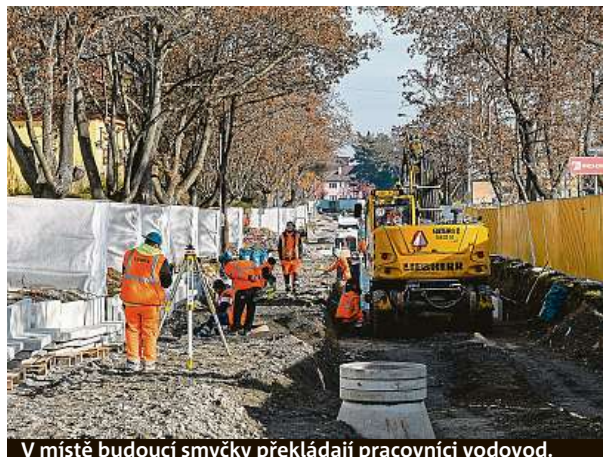
V místě budoucí smyčky překládají pracovníci vodovod.
