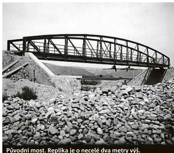
Původní most. Replika je o necelé dva metry výš.
