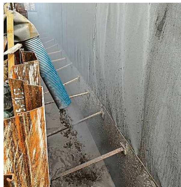
Plavení fluidního popílku a výroba aditivovaného granulátu na dálnici D3 v úseku Úsilné–Hodějovice
