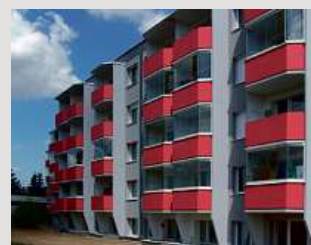
→ Realizace přistavěných lodžií - včetně bytů, kde dříve balkony nebyly
